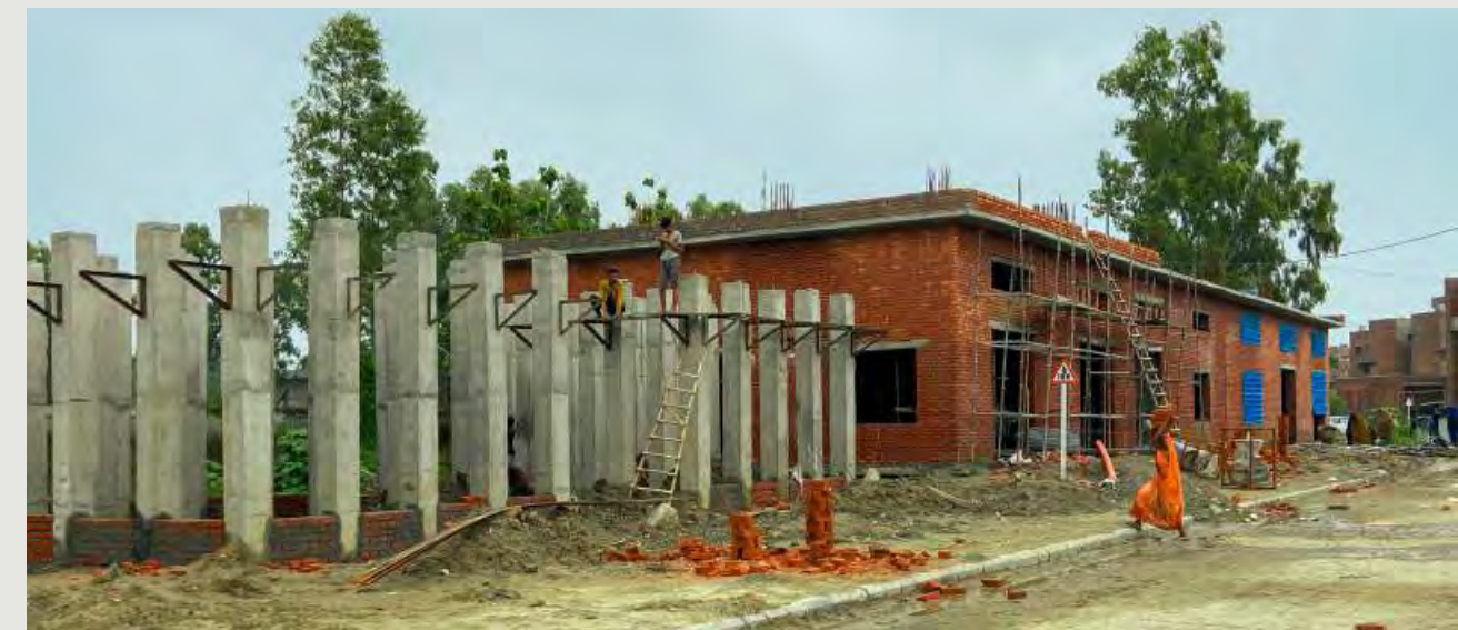
निर्माणाधीन एचवीएसी प्लांट
